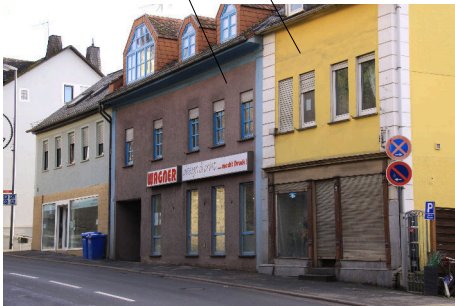
Aktueller Zustand. Bis auf die Quaderung wurden alle Gliederungselemente entfernt
