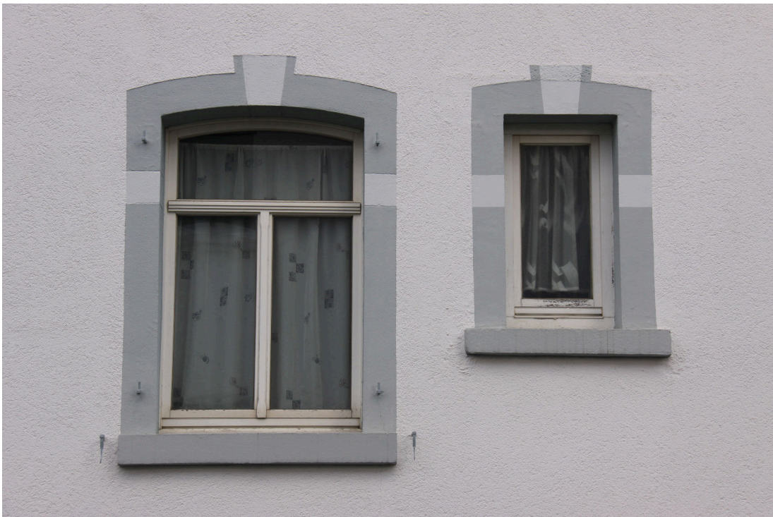
Beispiele von Holzfenstern in einer auf das Baualter des jeweiligen Gebäudes abgestimmten Teilung und Dimensionierung.
