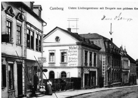
Historisches Foto mit Gesimsen, Quaderung, Fenstereinfassungen und Fensterverdachungen
